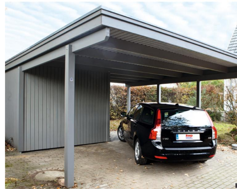
**1** EINZELCARPORT (BSH) mit Zinkleiste und größerem Dachüberstand vorn links.
